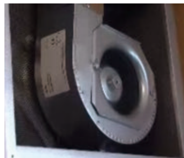
設置完成写真
