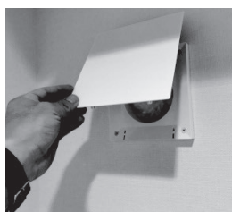
③表面カバーの上のツメ2箇所をアダプターに押し込み固定します
