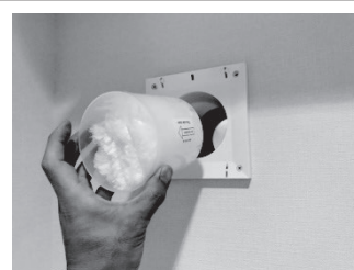
②四方4か所をビス止めて固定したアダプターにフリマーフィルターを挿入します
