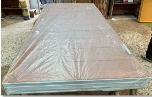
ビニールで玄関ドア全体を養生
